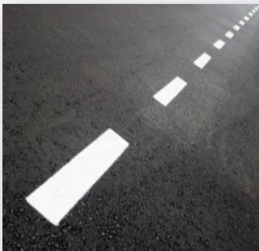
Faixas do pavimento
