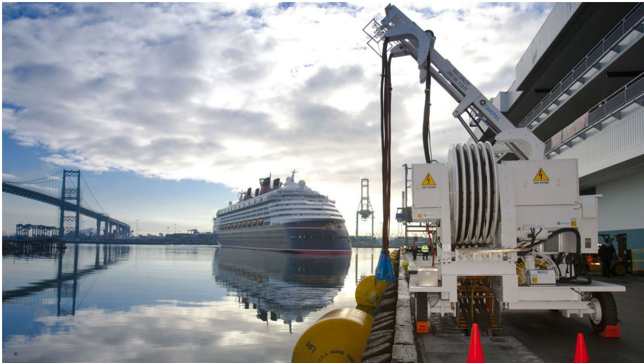
Suministro de energía eléctrica en el Puerto de Los Ángeles (Fuente de la imagen: Maritime Executive)
