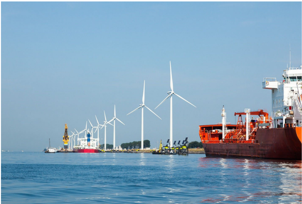
Turbinas eólicas en la costa de un puerto (Fuente de la imagen: Adobe stock)
