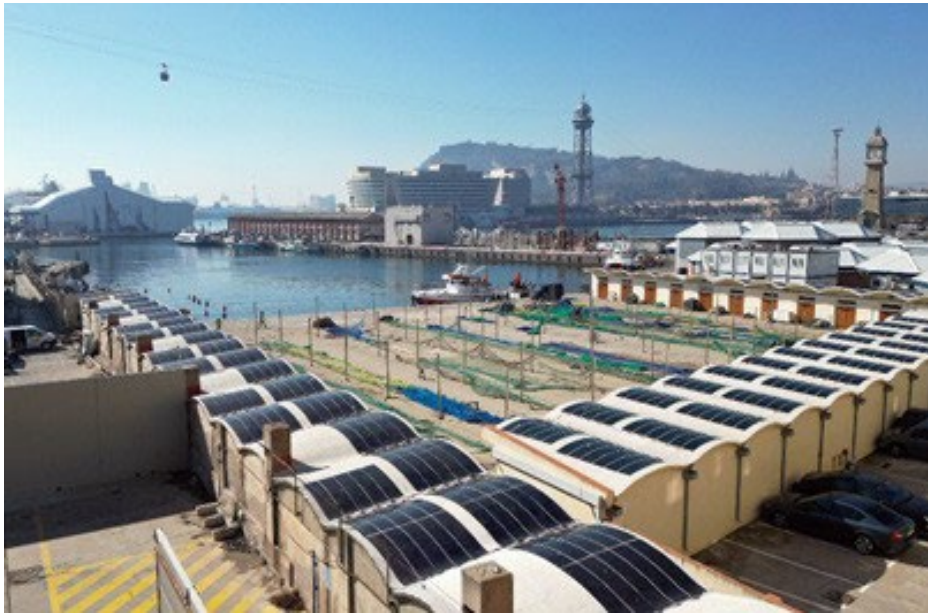
Película solar instalada en azoteas de Barcelona (Fuente de la imagen: Optics.org)
